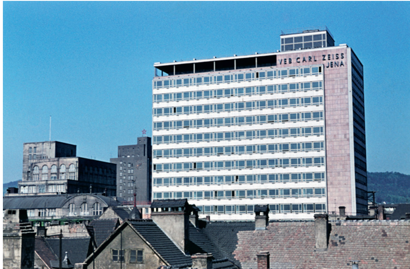
Forschungshochhaus B59 kurz vor der Fertigstellung
