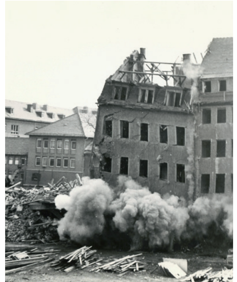
Abriss Häuser an der Südseite des Eichplatzes (Leutrastraße)
