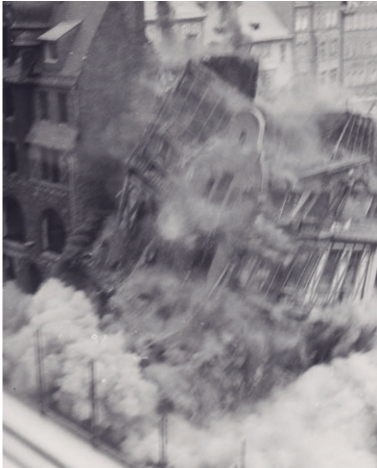
Abriss Haus Leutrastraße 22
