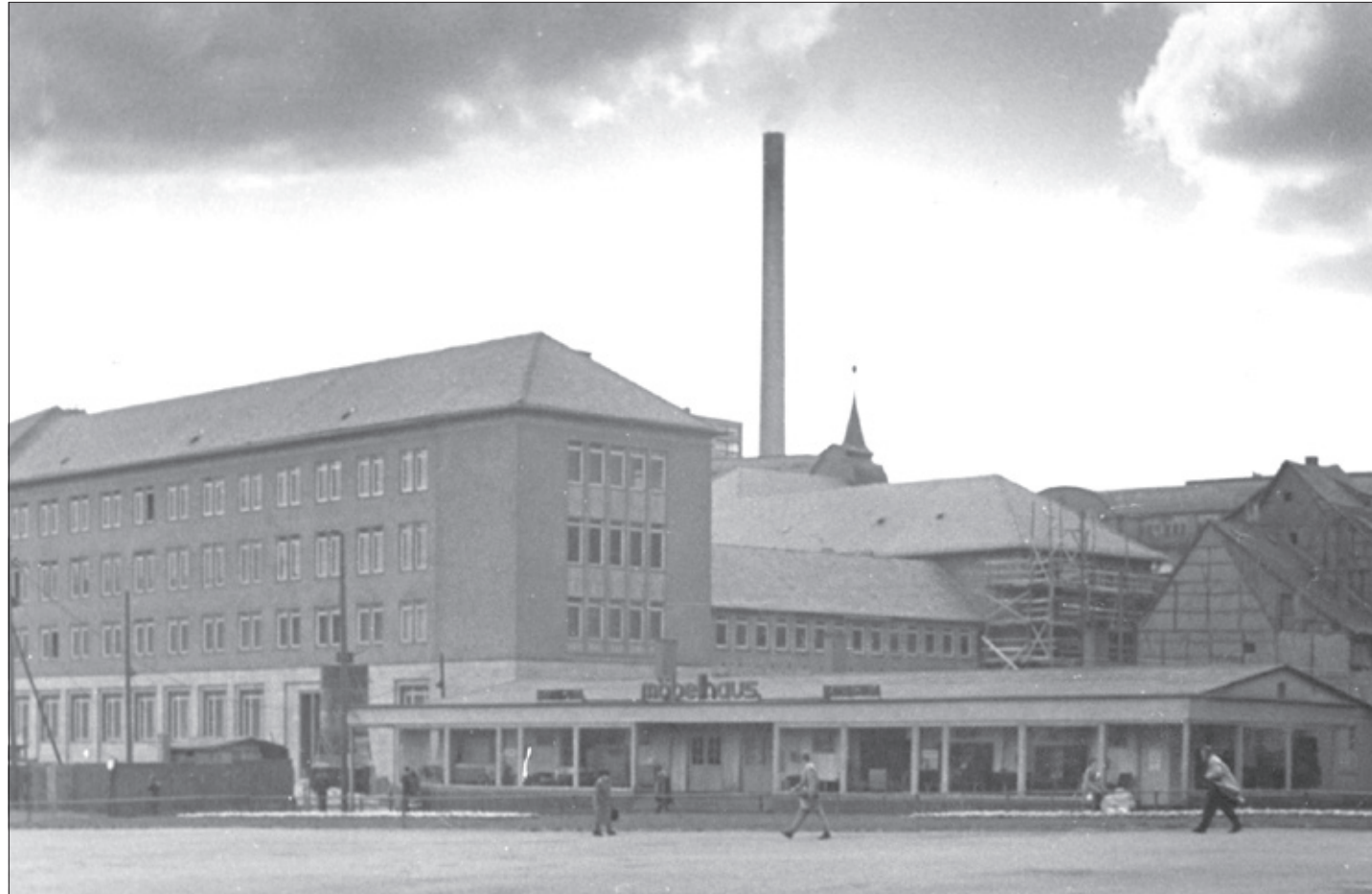
1956 eröffnet: die Möbelbaracke an der Westseite des »Zentralen Platzes«
