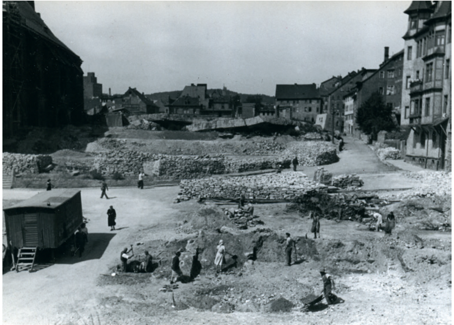
Enttrümmerung hinter der Kirche (im Hintergrund der gesprengte Bunker)
